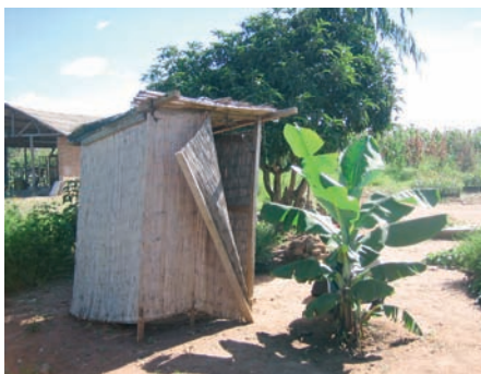
Photo 3-39 : Superstructure en matériaux locaux.
