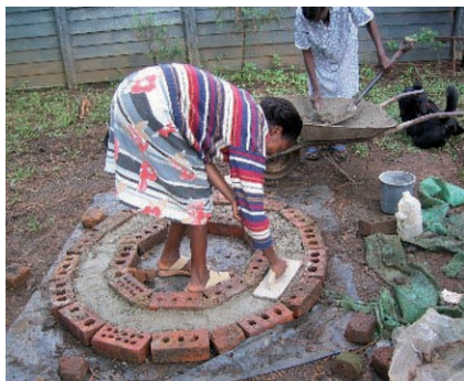
Photo 3-16 : Nivellement du béton.
