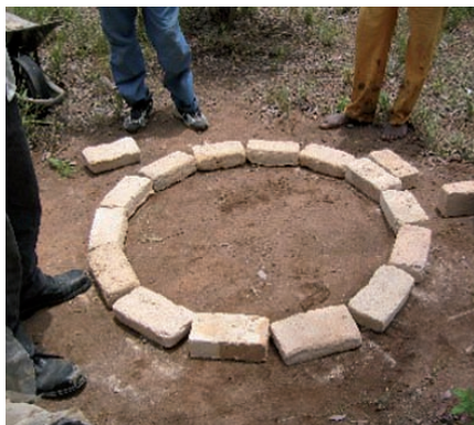
Photo 3-5 : Ceinture de briques pour le moule.
