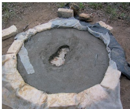
Photo 3-9 : Le moule après le retrait des briques d'insertion du trou de défécation.
