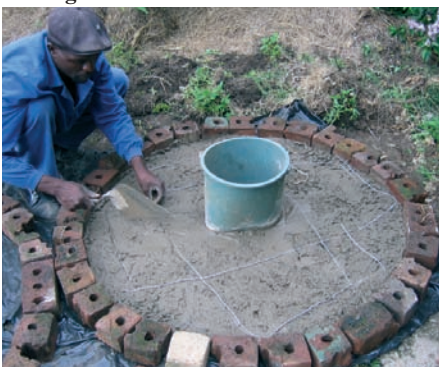
Photo 3-26 : Ajout d'armature pour renforcer.
