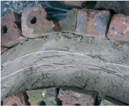
Photo 3-31: Ajout de fils de fer pour renforcement.
