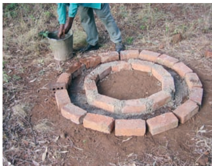
Photo 3-43 : Utilisation de briques pour faire le soubassement.
