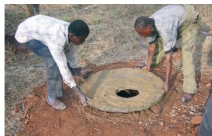
Photo 3-49 : Pose de la dalle sur le soubassement
