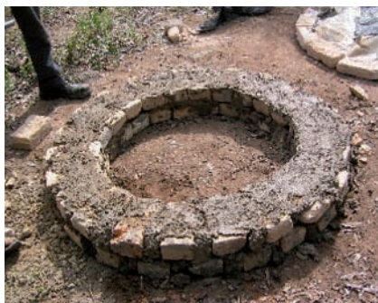
Photo 3-12 : Finalisation du soubassement en briques.
