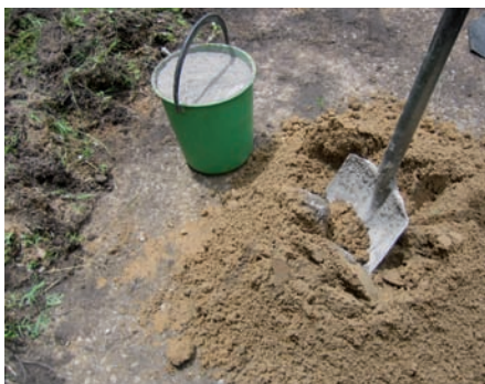
Photo 3-24 : Mélange du ciment au sable mélange
