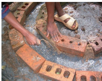
Photo 3-14 : Remplissage de l'espace créé par les briques internes.
