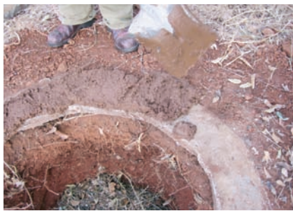
Photo 3-48 : Mortier étalé sur le soubassement.
