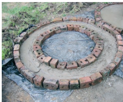
Photo 3-30 : Mélange de béton dans le moule
