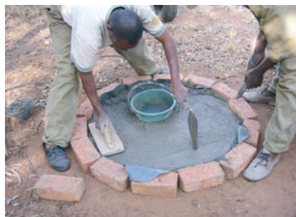
Photo 3-42 : Nivellement du mélange de béton
