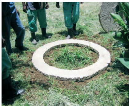
Photo 3-35: Placement du soubassement de béton
