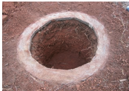
Photo 3-46 : Une fosse creusée à l'intérieur du soubassement.
