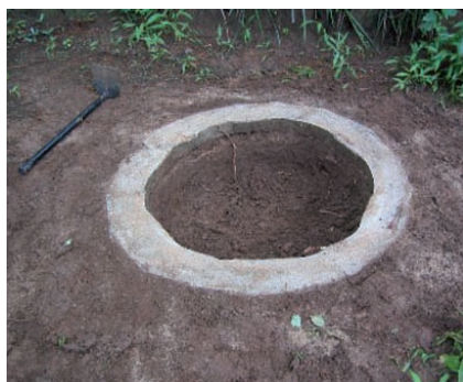
Photo 3-18 : Creusement du trou à l'intérieur du soubassement.
