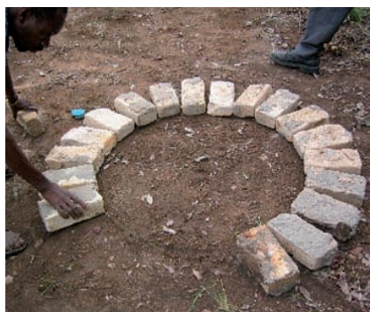
Photo 3-10 : Réalisation du soubassement en briques.
